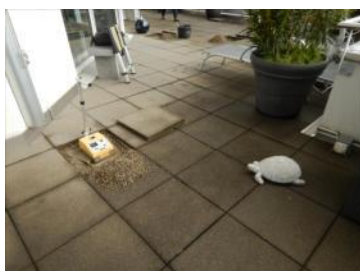
Feuchtigkeitsmessung auf Balkon durch die Dachhaut hindurch, für rasche Orientierung
